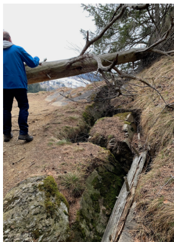
Abbildung 3.11: Der Riss in der Verlängerung der Felswand (Eigene Aufnahme).
