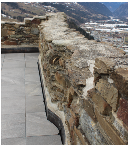
Abbildung 3.4: Die Einbuchtung der Mauer in der Region des Risses (eigene Aufnahme).
